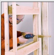
Крепление направляющих для лёгких конструкций
